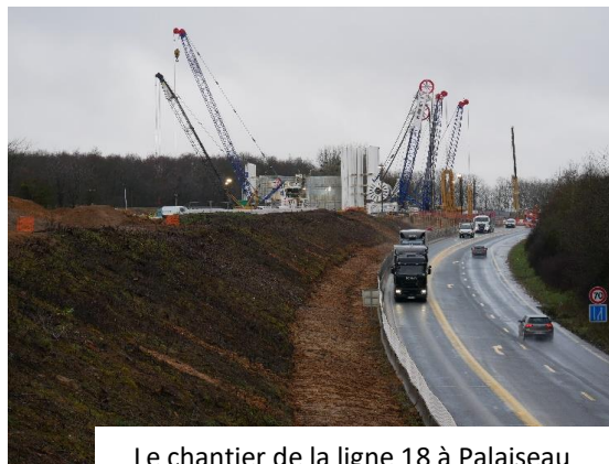
Le chantier de la ligne 18 à Palaiseau
